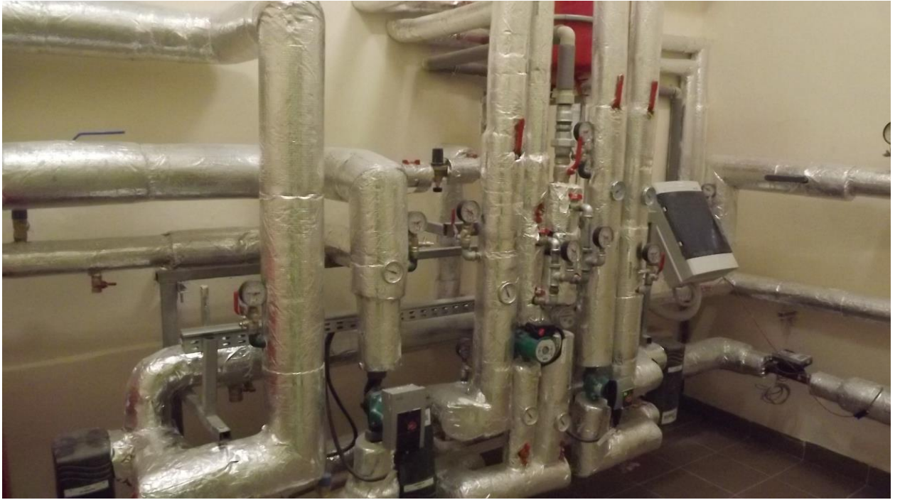
Akmenės kultūros namuose įrengtas šildymo mazgas
