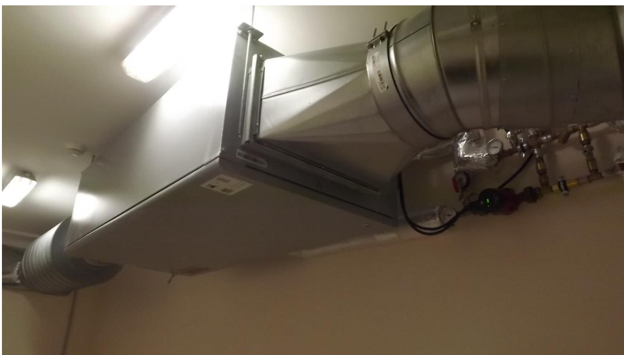
Suremontuota rekuperacinė sistema Akmenės kultūros namuose
