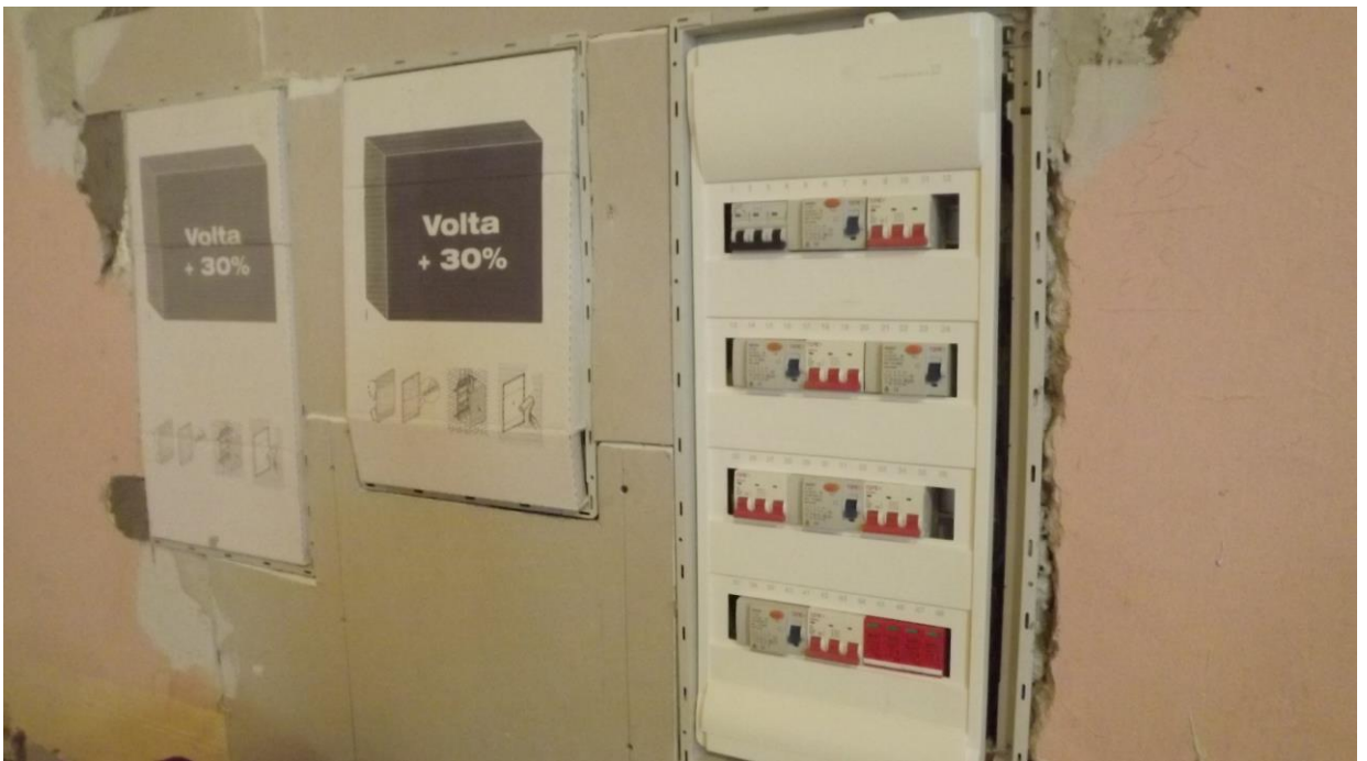
Elektros įrengimo darbai Akmenės kultūros namuose
